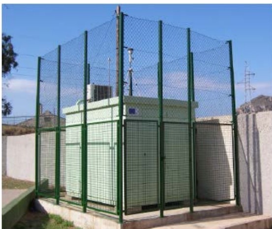
Fotografía de la estación medidora de la calidad del aire de Alumbres
