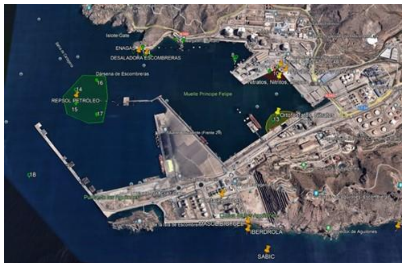
Vista aérea C. I. Repsol Cartagena. Terminal Marítimo
