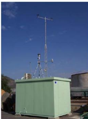
Fotografía de la estación medidora de la calidad del aire de Valle de Escombreras
